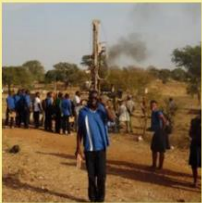
Bohrung für solare Wasserpumpe des Schulgartens von Guénon
