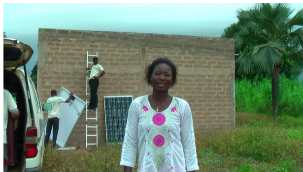
Solafrique installiert am Kindergarten
