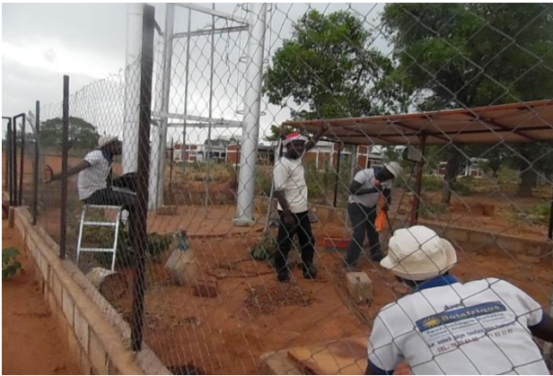
Reparatur der Solarpumpe im Jugendgefängnis
