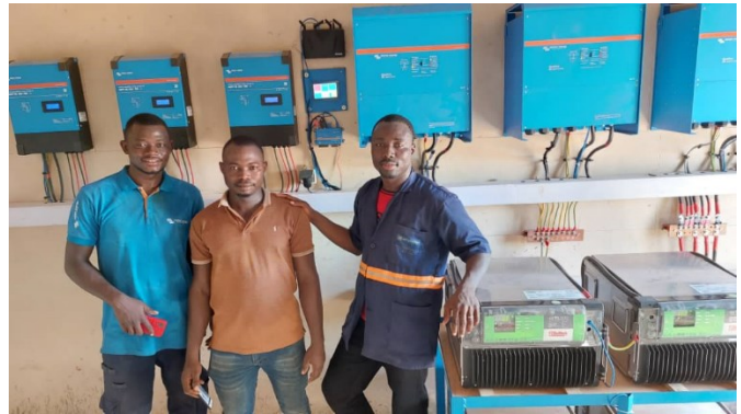
Herr Asso (rechts) mit Mitarbeitern im Batterieraum
