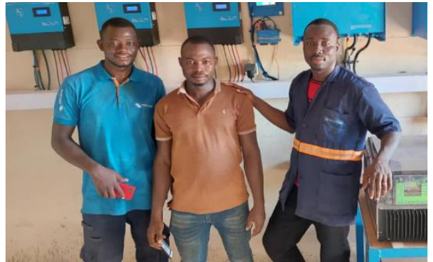
Herr Asso (rechts) mit Mitarbeitern im Batterieraum
