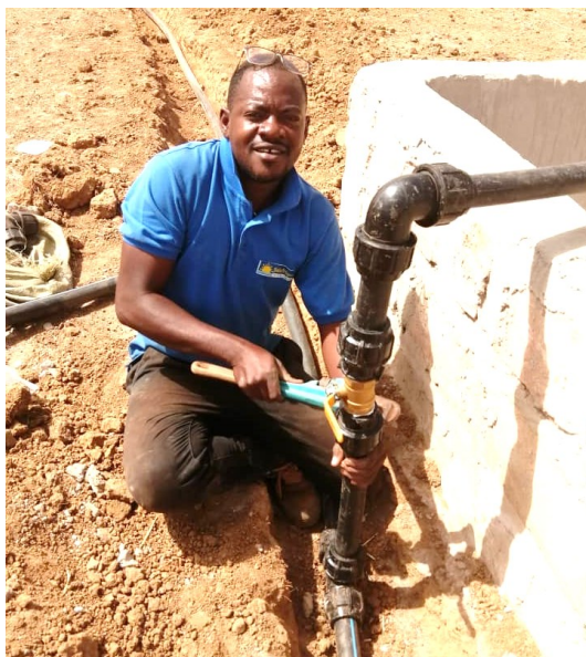
Jonas Konkobo bei der Installation eines Bassins
