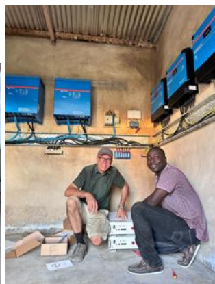
Links. Unser „Restaurant Village Solaire“ - der Betonboden hier ist wohl einzigartig weit und breit :-) Mitte: Montage erster Lithiumbatterien für das Minigrid, zusammen mit Geschäftsführer Asso Rechts: Hier wird in einem einfachen Ofen Plastikmüll in Tische umgeschmolzen...
