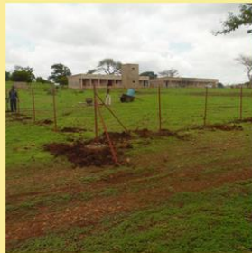
Le jardin scolaire du Lycée Guénon se dote d'une pompe solaire
