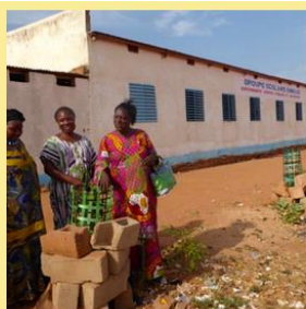
Le bâtiment de l'école Emmaüs avec des arbres fraîchement plantés
