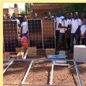
L'orphelinat Le Nid reçoit un éclairage solaire
