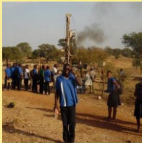
Forage pour la pompe solaire du jardin de l'école de Guénon
