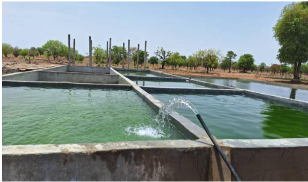
Bac d'élevage de tilapias avec irrigation solaire
